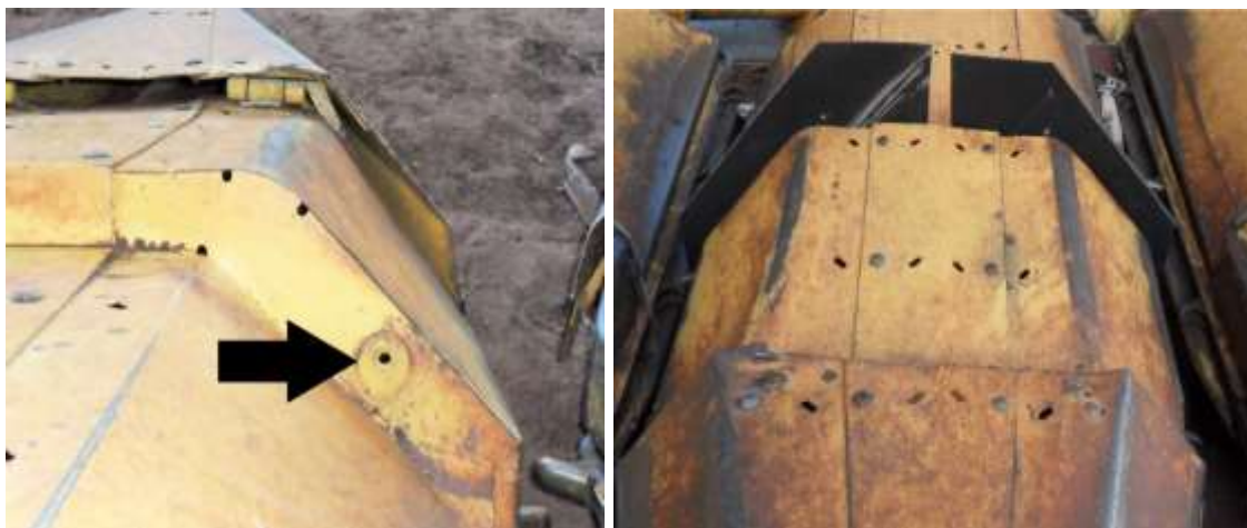
FOTO 4: Local da perfuração no divisor intermediário para a fixação da peça, e peças fixadas entre o divisor e o divisor intermediário.
