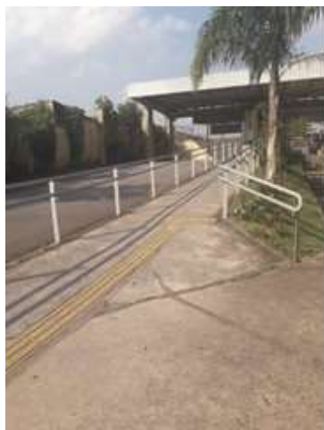
Figura 10: Rampa de acesso
