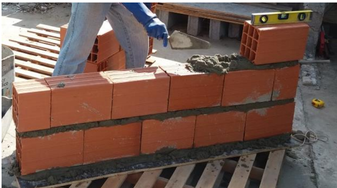
Figura 01 - Penúltima Fiada da 1ª Estrutura
