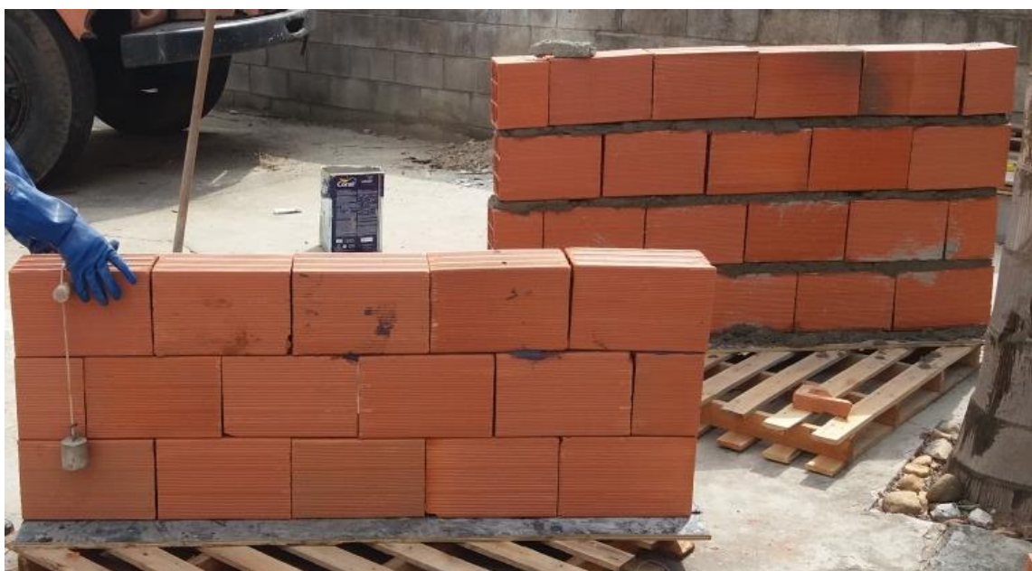
Figura 02 - Penúltima Fiada da 2ª Estrutura
