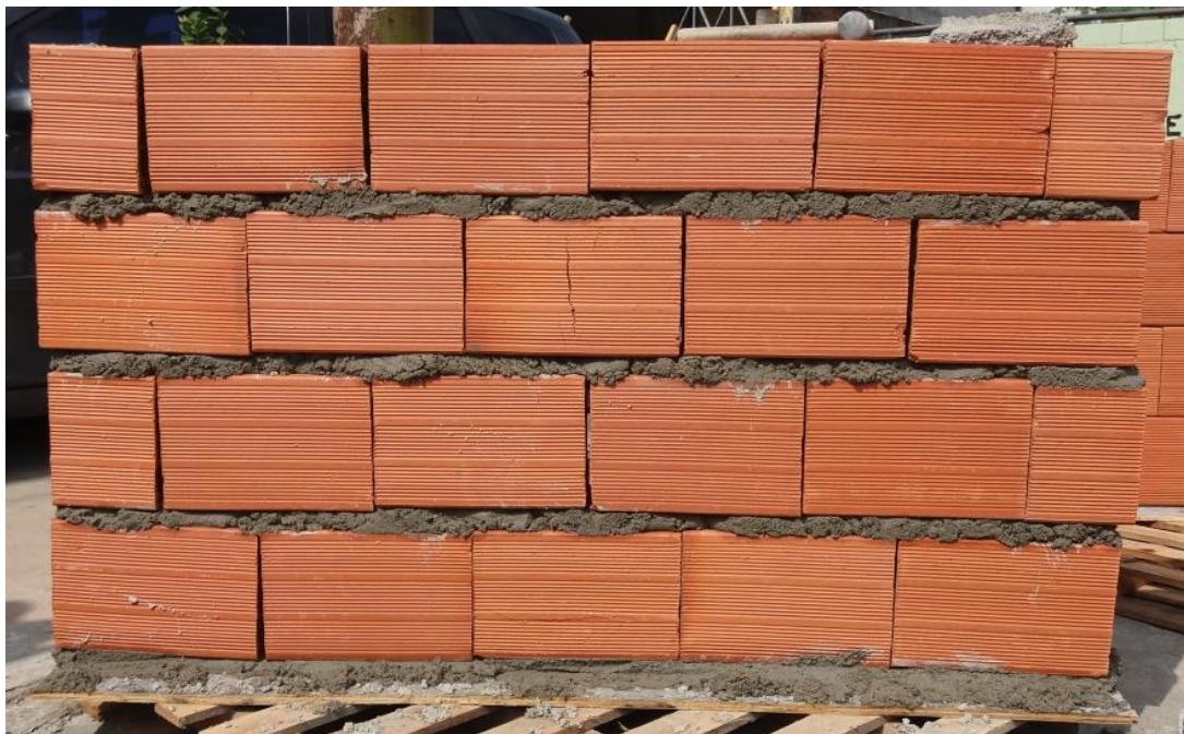
Figura 03 - Conclusão da 1ª Estrutura
