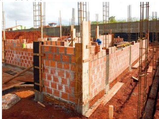
Figura 3 – Alvenaria Convencional com armaduras
