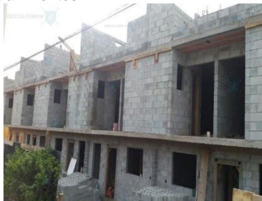
Figura 2 – Alvenaria Estrutural em dois pavimentos
