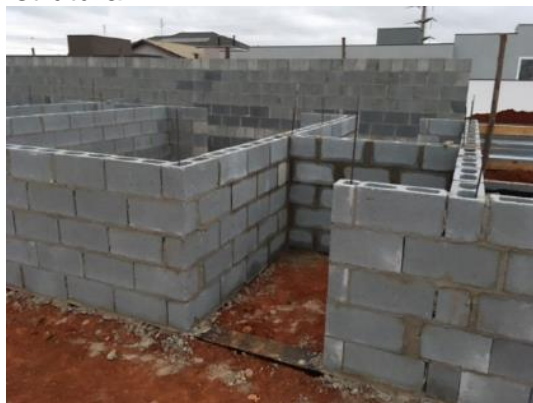
Figura 1 – Levantamento Alvenaria Estrutural
