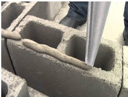
Figura 9 – aplicação de argamassa.
