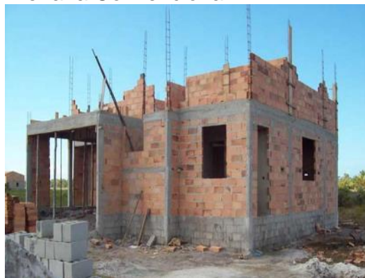
Figura 4 – Unidade Habitacional com Alvenaria Convencional
