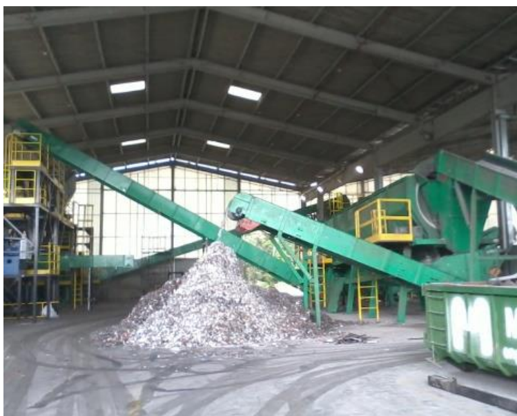
Figura 4 – Vista parcial da máquina de co-processamento
